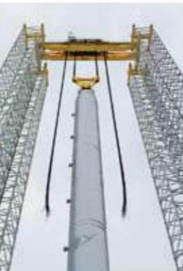
24 декабря 2013 года. Монтаж 4 реакторов гидрокрекинга на Ачинском НПЗ с помощью подъемно-транспортной системы B-SET
